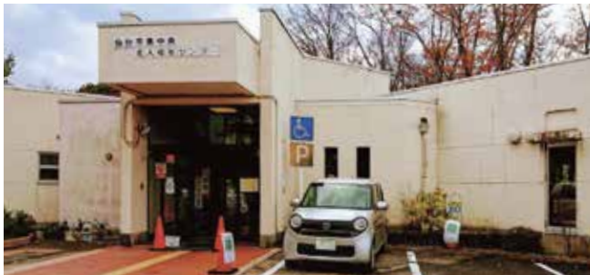
泉中央老人福祉センター(七北田管間)は、建築から45年が経過しています。
