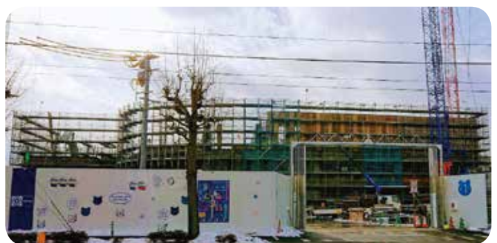
仙台徳洲会病院は、泉区高玉町に移転新築工事中。 完工は令和4年1月末の予定です。
